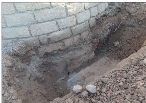
Calicata mecánica de observación
