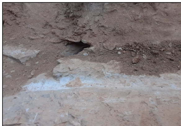
Sustrato de apoyo de la cimentación
