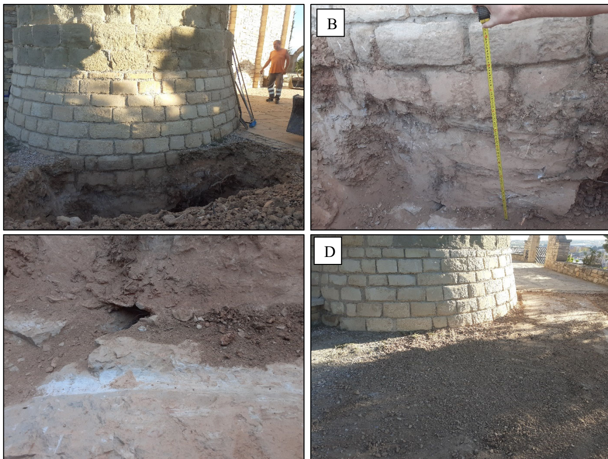
Figura 6. Estado y profundidad de la cimentación actual identificada en la zona de estudio. A) Visualización general de la calicata. B) Profundidad de la base de la cimentación. C) Sustrato donde se apoya la cimentación. D) Estado final de la calicata.
