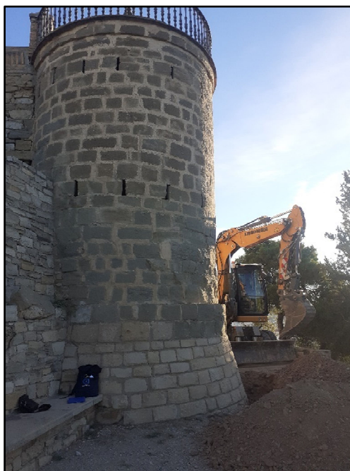
Figura 11. Maquinaria utilizada para la ejecución de la calicata mecánica.
